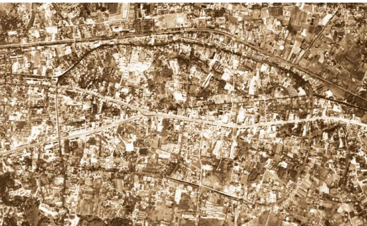
ภาพถ่ายทางอากาศบริเวณเมืองนครปฐมโบราณ
