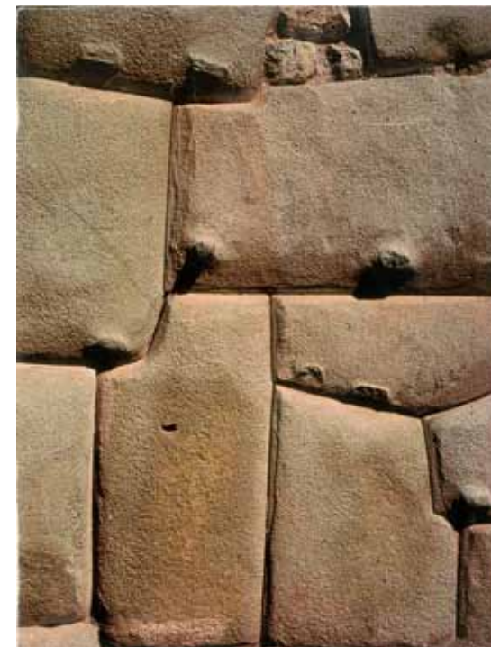
เทคโนโลยีก่อสร้างอาคารของชาวอินคา ที่ก้อนหิน ถูกสกัดจนประสานกันสนิทเรียบ
